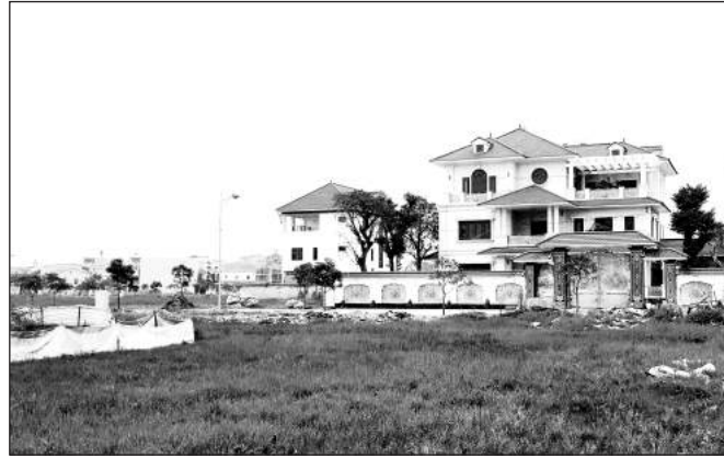
Những biệt thự 3 tầng tại khu đô thị Nam Lê Lợi.
