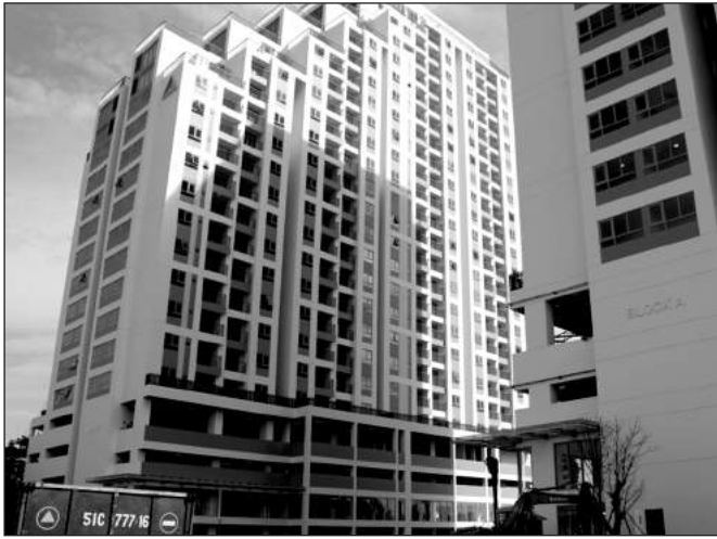
Dự án Luxgarden đang hoàn thành.
